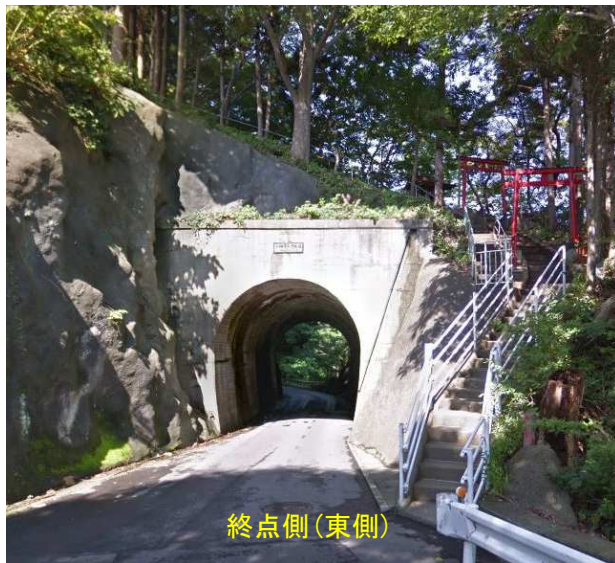
小袖第二号隧道 トンネルはアーチ型のコンクリートで構成
