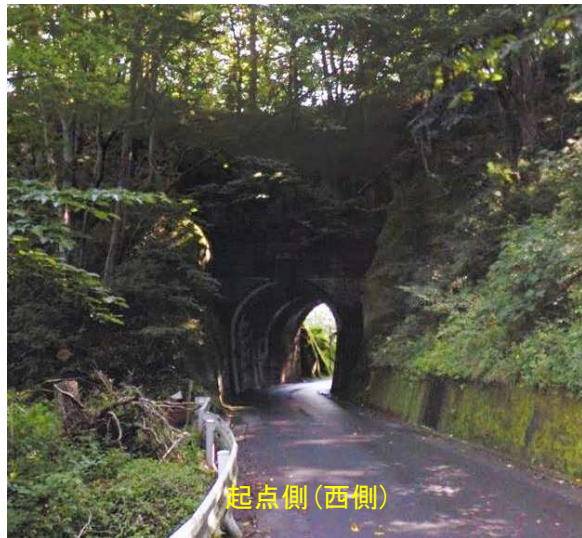
小袖第一号隧道 トンネルはアーチ型のコンクリートで構成
