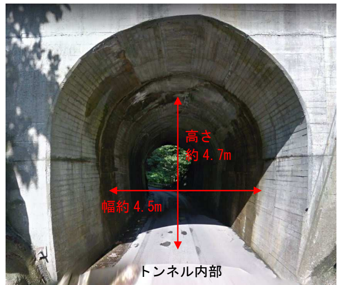
小袖第二号隧道 トンネルはアーチ型のコンクリートで構成
