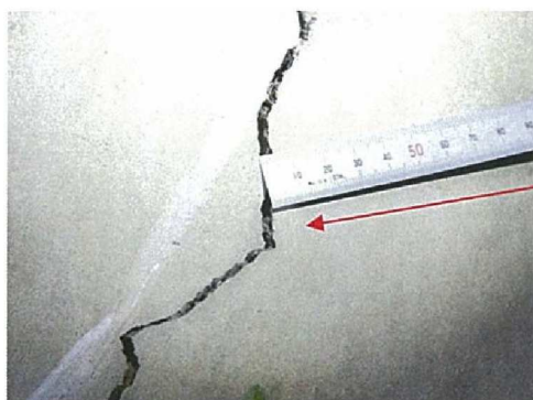
コンクリートひび割れの例
