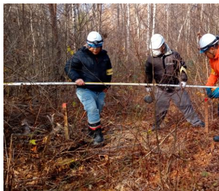
アンカー位置出し
