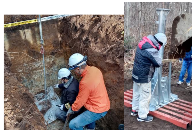
観測塔基礎工事
