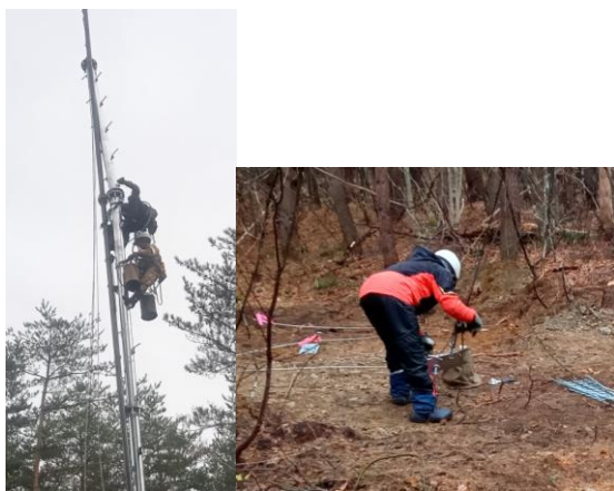
観測塔設置工事
