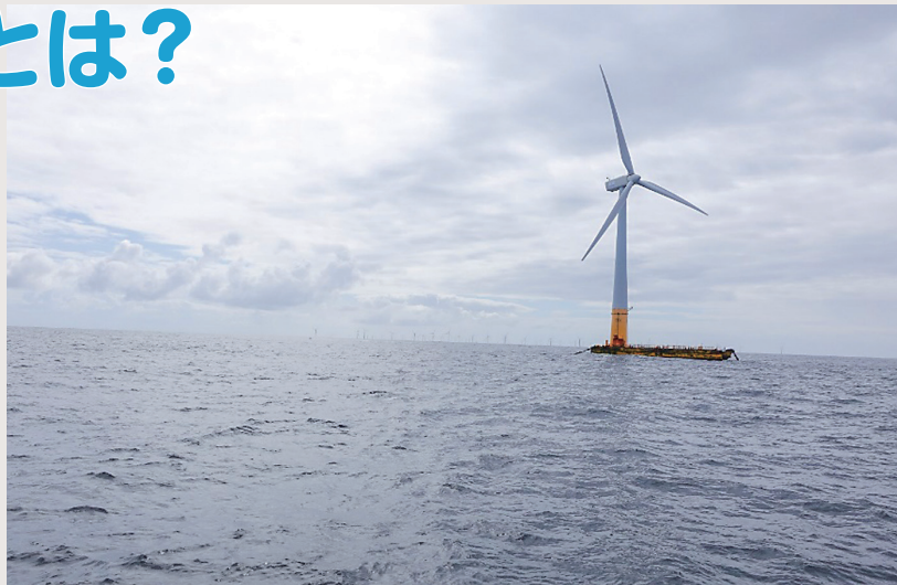
▲ フロージェン：フランスの浮体式洋上風力発電の実証機
