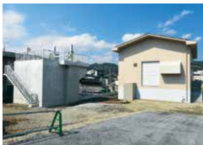
整備中の新井田ポンプ場。25mプール(360m)の水を約1分で排水
