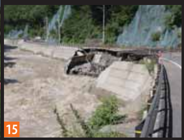
11/ 洪水による犠牲者が出た山根町深田地区。増水した川によって流された軽自動車（山根町川又） 12/ 数カ所で電柱が倒れるなどして、山根地区一帯が停電（山根町小田瀬） 13/ 旧道に架かる橋が損壊した山根町たもの木地区 14/ 川が氾濫し、道路の損壊や家屋への浸水被害が発生（山形町霜畑） 15/ 激しい流れに削られ、のり面が崩落した国道281号戸呂町口付近。通行止めにより、山形町との往来が困難に 16/ 5日、孤立世帯の避難困難者をヘリで輸送（山根町）
