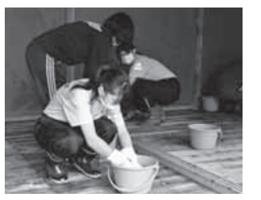
室内の床や壁面を清掃する大川目中学校の生徒たち
