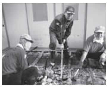
手際よく床板をはがし、泥をかき出していきます
