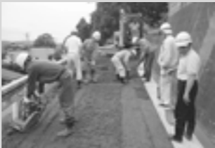
寺里町内会（山崎石雄会長）・側溝の設置作業
