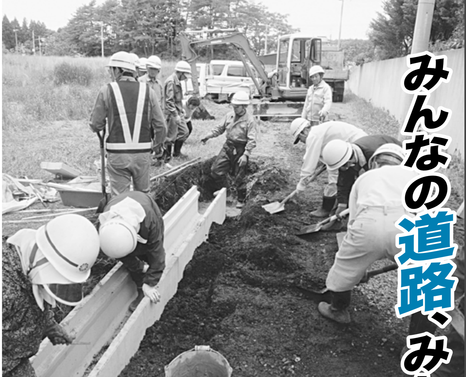
保土沢町内会（越戸千江会長）と市による側溝の整備作業
