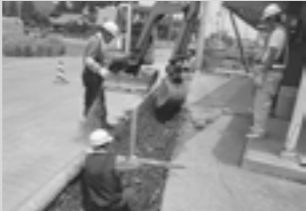
岩瀬張町内会（関添文雄会長）・側溝の設置作業
