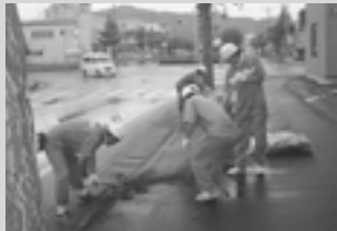
高源機械第1ブロック（米澤隆男部長）・道路の除草作業
