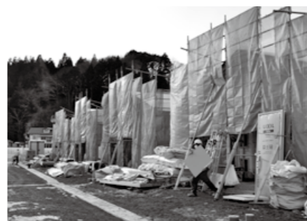
建設が進む久慈湊・大崎地区の災害公営住宅
