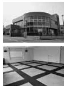
上…新庁舎の外観 下…2階大会議室
