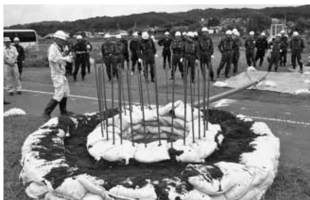
釜段工法を完成させた後、特徴や効果を学ぶ消防団員ら
