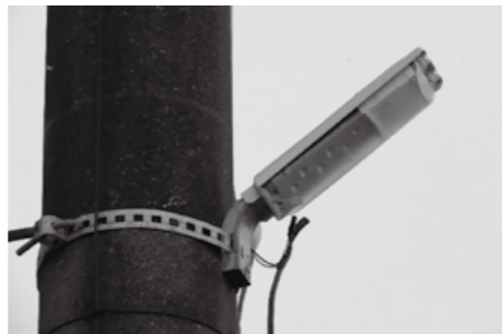
LED防犯灯は従来の防犯灯と比べ省エネで電気量も削減できます
