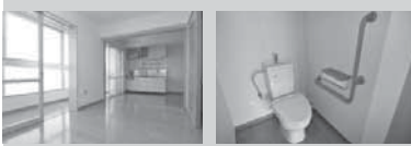
広く、段差のない部屋。トイレや浴室、玄関には手すりも付いています
