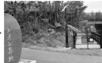
大湊公葬地前に設置された避難階段
