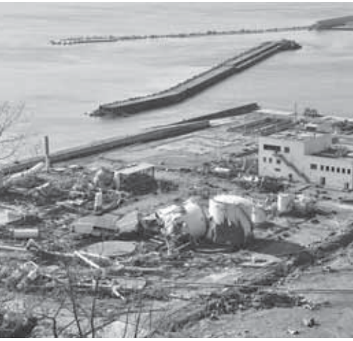
地上施設がほぼ全壊した国家石油備蓄基地。辺り一面が信じられない光景に
