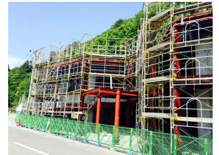
建設中のもぐらんぴあ管理棟
