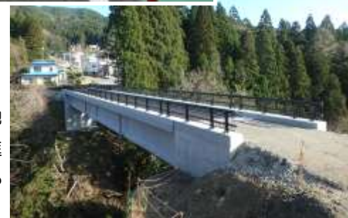
宇部町久喜地区に整備が進められている避難道路
