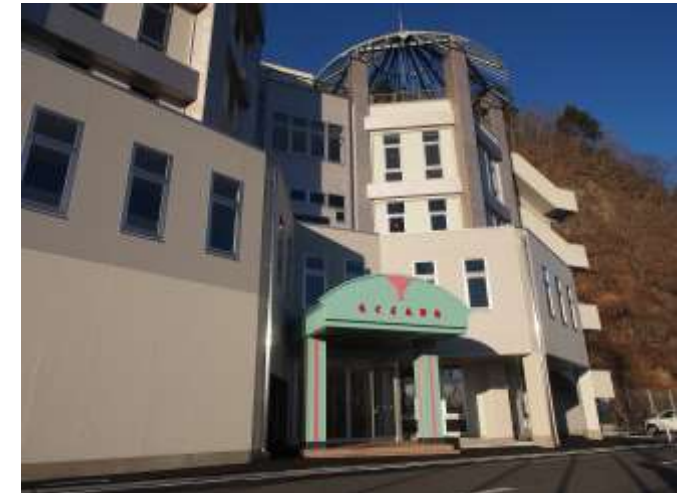
5階建てで生まれ変わった管理棟
