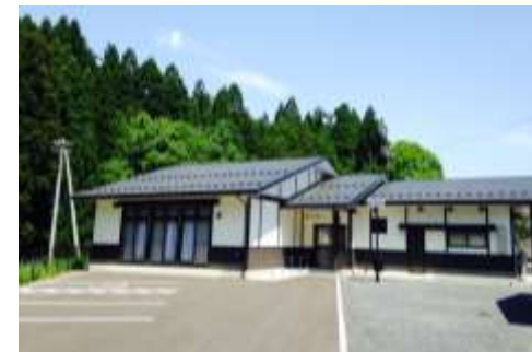
長内町元木沢地区に整備した津波避難施設
