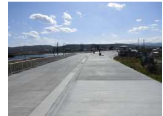
整備中の久慈湊防潮堤
