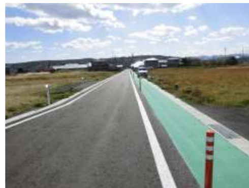
久慈湊小学校前に整備が完了した避難道路
