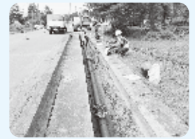
水道管の更新工事 (口径150mm)
