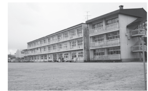
築50年以上経過した久慈湊小学校の現校舎
