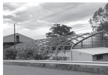
待浜地区プールの屋根の骨組
