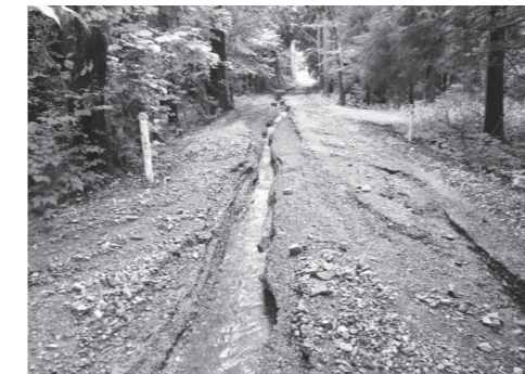
路面の砂利が流された宇部町の市道小倉線
