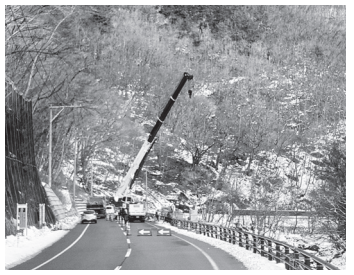
戸呂町・案内間の新トンネル工事着手予定箇所
