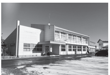
定期的な修繕を行ってきた久慈職業訓練センター
