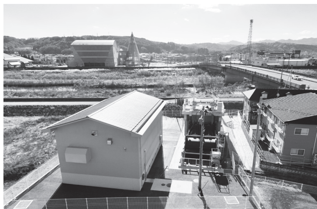
北側から見た新井田雨水排水ポンプ場
