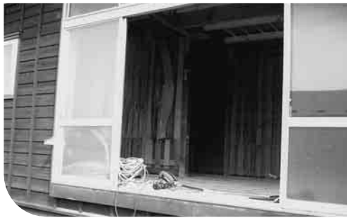
改修中の住宅
