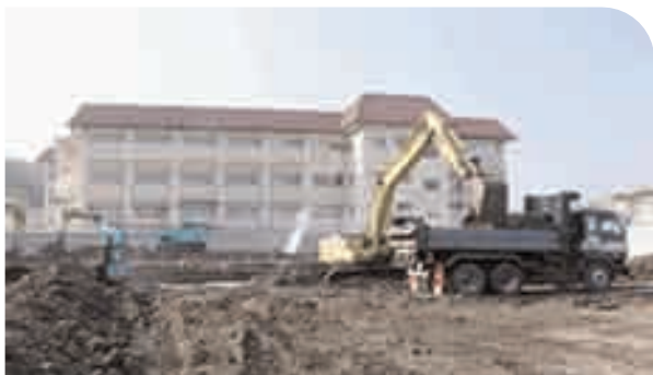
工事に着手した長中隣接地の新学校給食センター
