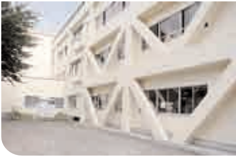
耐震化工事が終わった長内小学校
