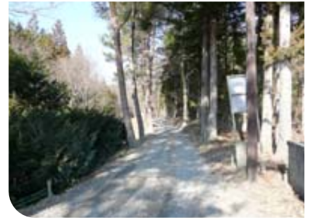
延長整備が必要な市道大川目線
