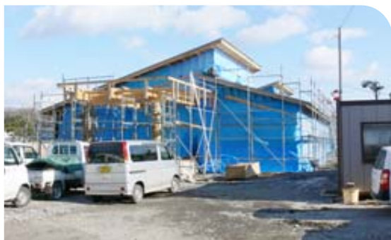
湊町に建設中の居宅介護施設
