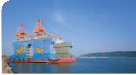
早期の完成が望まれる湾口防波堤
