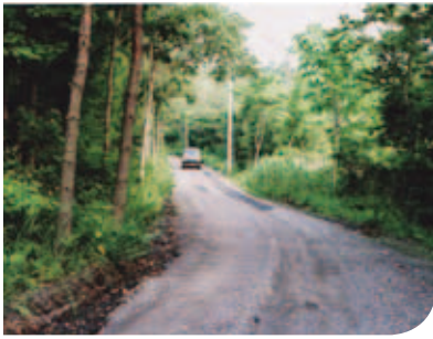
拡幅整備が必要な市道二子小袖沢線
