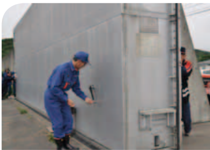
人力で開閉する防潮ゲート
