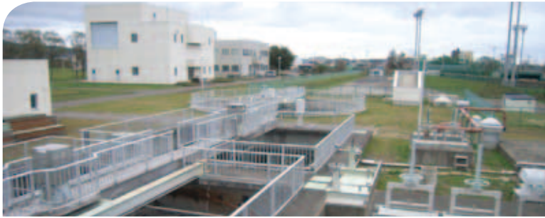
久慈市浄化センター
