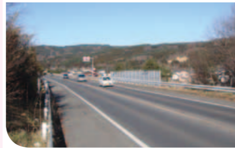
夏井地区の八戸・久慈自動車道
