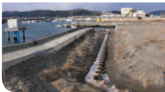
土留め工事に着工した堀込地区の小型船係留施設
