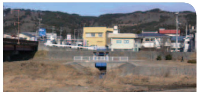
ゲートポンプの設置が望まれる新中の橋水門
