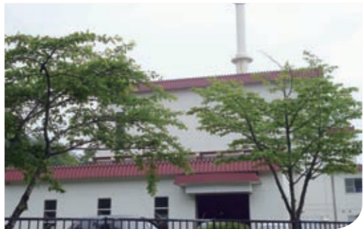
現在の久慈地区ごみ焼却場
