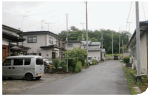
消防水利が待たれる上長内住宅地
