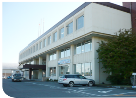
エレベーター設置がのぞまれる本庁舎
