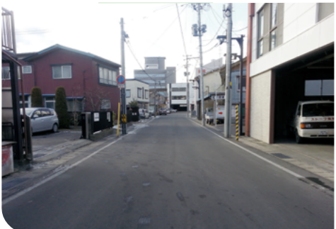
排水処理対策が望まれる久慈郵便局付近
