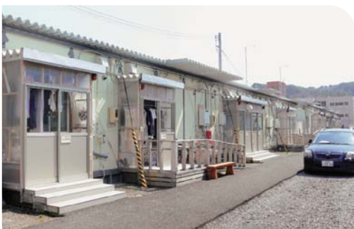
市内の仮設住宅
