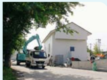
工事が進む川崎町雨水ポンプ場
