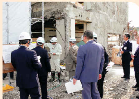
屋内運動場建設地を視察する委員会
