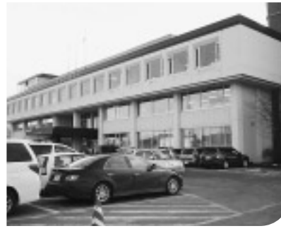
経年劣化が進む市庁舎
