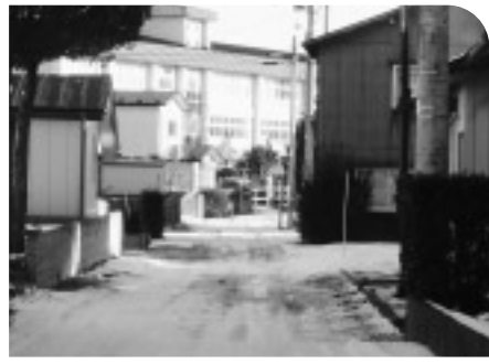
排水施設整備が望まれる久慈高校西部地区
