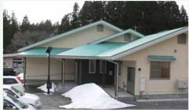
新たに設置された久喜地区防災センター
