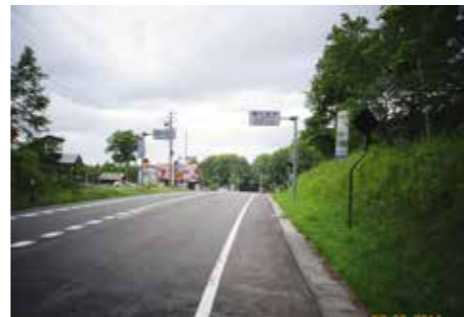
早期の整備が望まれる国道281号平庭高原付近
