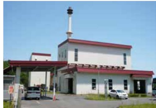
早期整備が望まれるごみ焼却場
