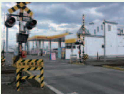
歩道設置予定の久慈街道踏切
