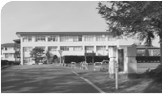
土木科存続が強く望まれる久慈工業高校
