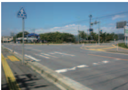
信号機設置が望まれる大成橋南側交差点
