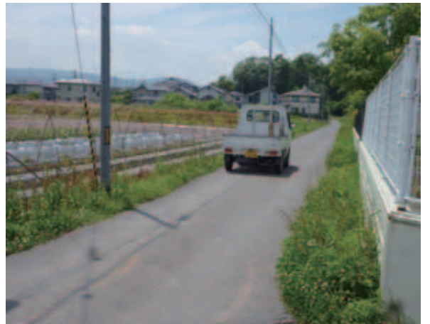
早期拡幅が望まれる市道ひばり保育園通り線と田面東線
