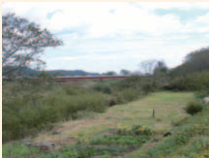
河川堤防が未整備のままの大成橋上流
