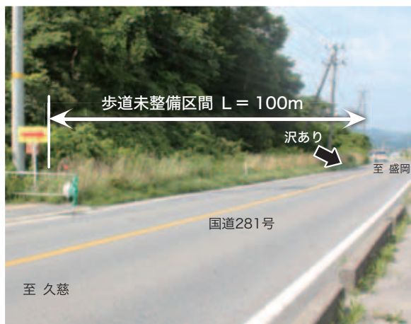
歩道が分断し事故のおそれがある 国道281号久慈自動車学校付近
