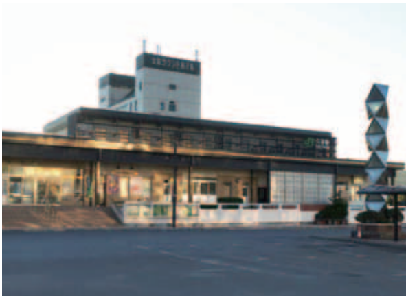
にぎわいの創出が期待される久慈駅前周辺整備
