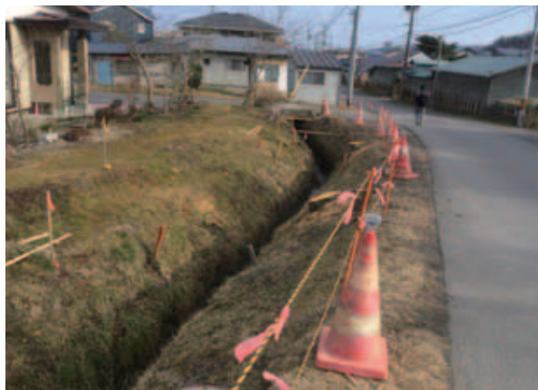
安全対策の措置が必要な用水路
