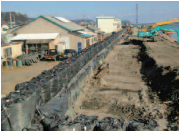
河川堤防のかさ上げが進む久慈湊地区
