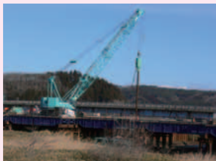
架け替え工事中の湊橋
