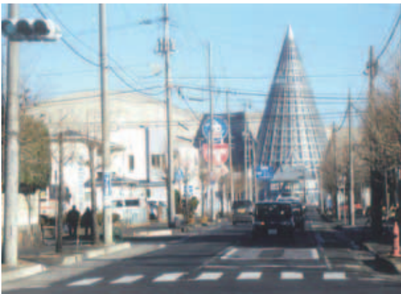
無電柱化整備が進められている 駅東口からアンバーホールの区間
