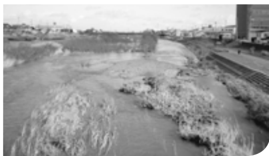
立木等が目につく久慈川上の橋付近
