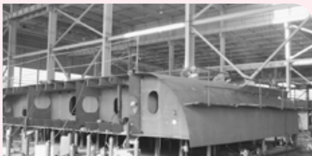
北日本造船(株)久慈工場内の作業風景
