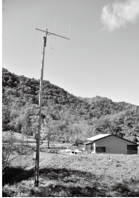
防災行政無線の難聴世帯に設置された受信アンテナ（上）と住宅の玄関に設置された戸別受信機（下・矢印）。それぞれをケーブルで接続して、放送の電波を受信しています
