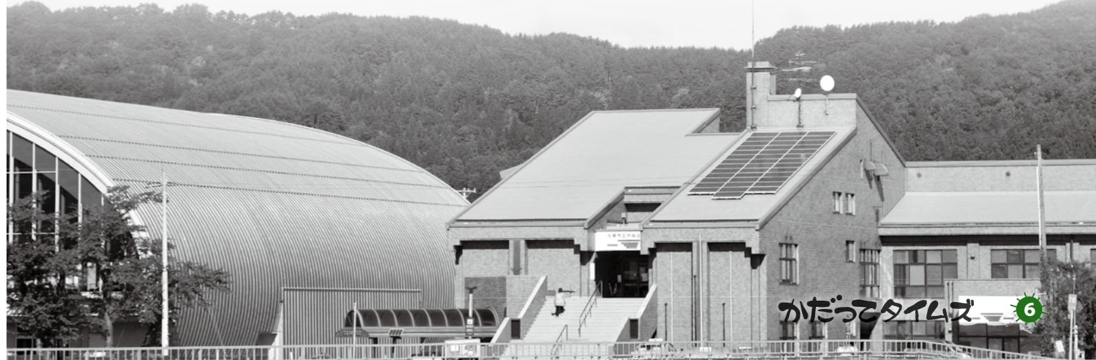
災害時の避難所となる中央市民センターの屋根に設置されている太陽光発電設備
