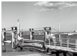
玉の脇漁港に設備されている 上架施設
