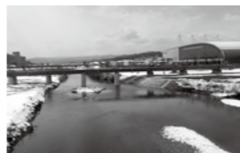
河道掘削が望まれる久慈橋 上流
