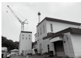
長寿命化工事が進められている久慈地区ごみ焼却場
