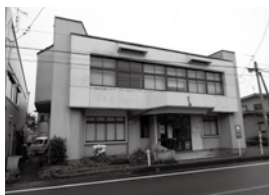
老朽化が進む類似公民館
