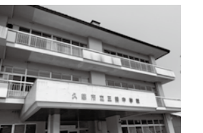
屋根の錆がひどく、補修が必要な三崎中学校の校舎
