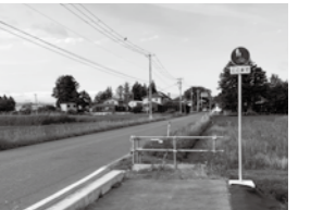
工事が進まない市道上長内日吉町線の歩道
