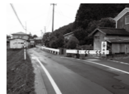
道路の改良工事が休止している市道山岸線
