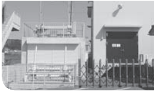
整備された中央地区ポンプ場
