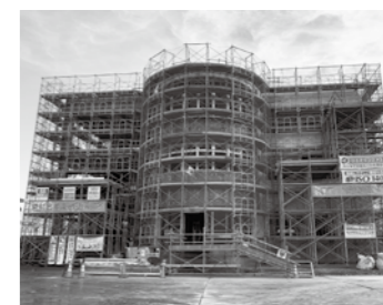
建設が進む情報交流センター
