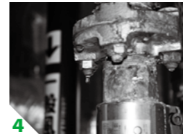
1/温泉をためるタンク内は通常時の2割程度 2/源泉のくみ上げポンプ 3/施設内の雨漏り 4/ボイラー室の配管も腐食や水漏れ 5/食堂のエアコンも限界 6/屋根も塗装や修繕が必要
