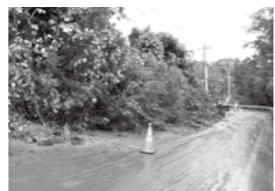
大雨で土砂が崩れ、道路の半分が埋まった市道旭町線
