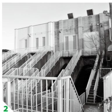
1/長内川と小屋畑川の合流部付近の河床掘削作業。これまでに蓄積した大量の土砂が撤去されています 2/大雨時に大量の水をくみあげて川に放流するポンプ場。未整備地区の早期解消が望めます 3/河川の氾濫により生活橋が流失した箇所も多数
