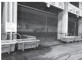
防鳥ネットのみが設置される市営魚市場
