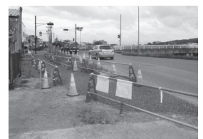
建物が撤去された長内橋付近の交差点（10月2日現在）
