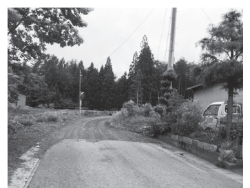
小久慈町秋葉地区内の未整備道路
