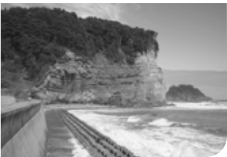
水尻地区のがけ地崩落現場
