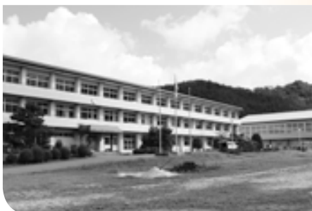
改修・整備が進む旧商業高校
