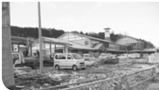
道の駅併設が計画されている工事中の核施設
